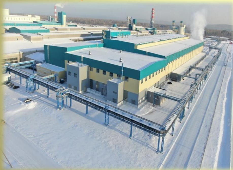
Строительство Тайшетского Алюминиевого завода
