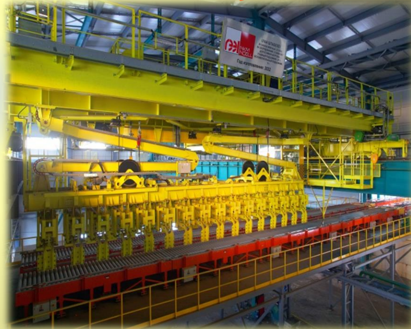
Строительство Тайшетской Анодной фабрики
